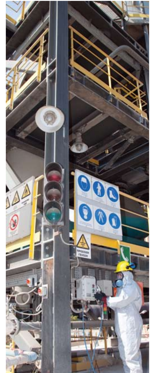
Εργοστάσιο τσιμέντου TITAN, Καμάρι, 2009
